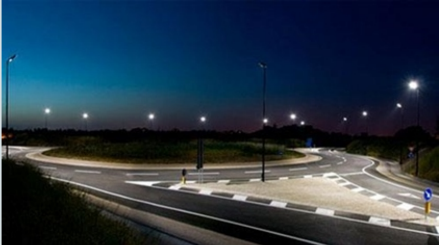
CENTRALE - VI - ITALY
